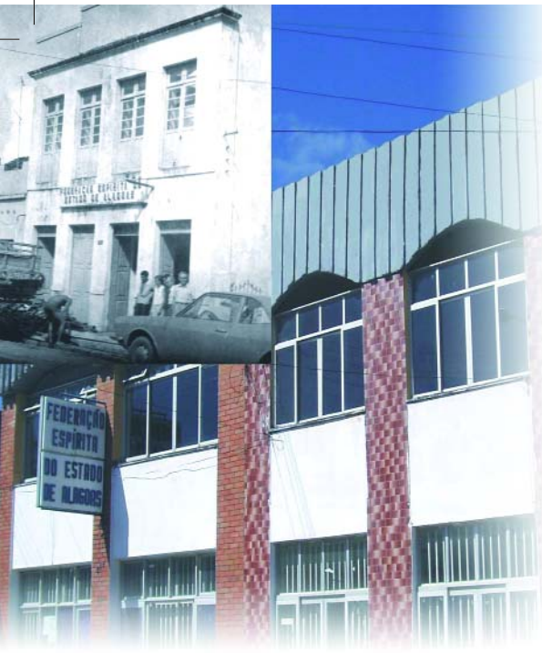
Sede da Federação Espírita do Estado de Alagoas
