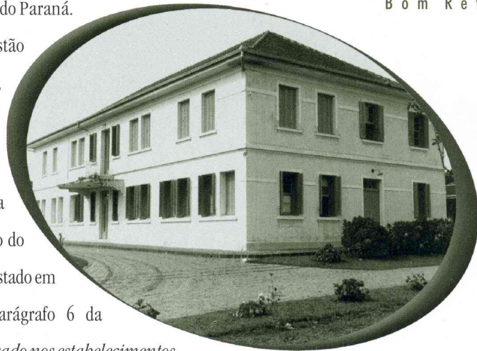
Sanatório Bom Retiro
