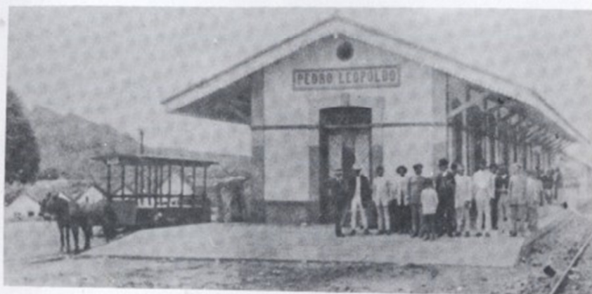
Primeira estação da estrada de ferro em Pedro Leopoldo - MG.
